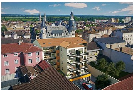
Construction de logements Le Royal
