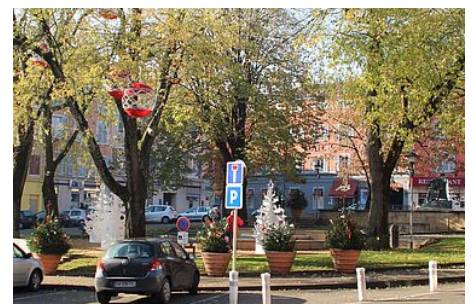
Rénovation des places aux Herbes, Poissonnière et de la Barre
