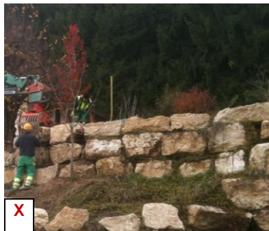
Enrochement de type cyclopéen
