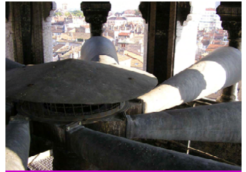
Sirène du réseau national d'alerte
