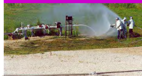
Equipes d'intervention composées de 2 portes lances qui créent un rideau d'eau pour s'approcher de la vanne et d'un coupeur de vanne d'alimentation.
